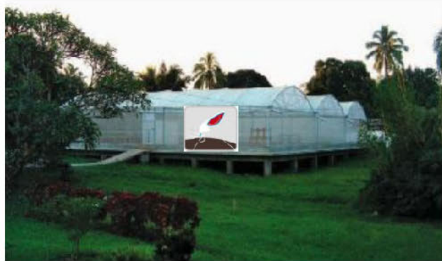
[그림 31] 유전자변형 모기 생산시설 전경
