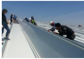
솔라루프 설치 (신규 지붕재)
