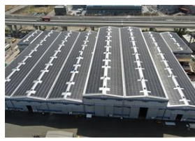
친환경기업 인증 차별화 된 시공 전경
